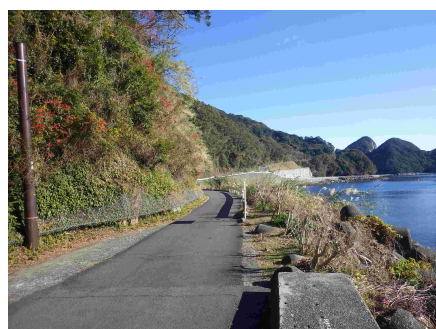
国道 311 号狭隘箇所[熊野市]
