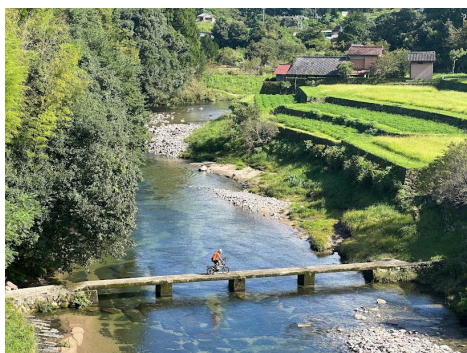
尾川川沈下橋[熊野市]
