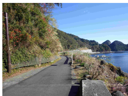
国道 311 号 狭隘箇所[熊野市]
