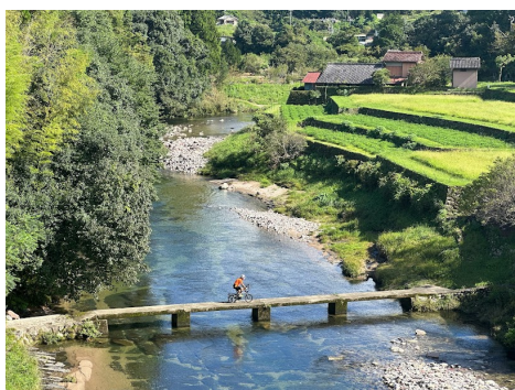
尾川川沈下橋[熊野市]
