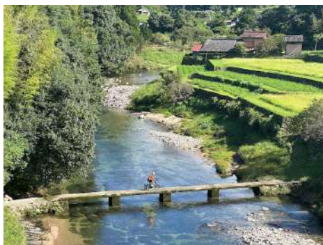
尾川川沈下橋[熊野市]
