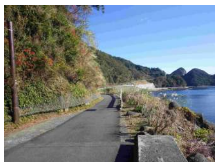
国道 311 号 狭隘箇所[熊野市]
